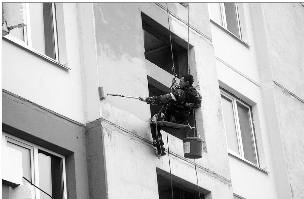
За последние четыре года в городе отремонтировано 648 многоквартирных домов — это лишь 8% от потребности. Более 1 500 домов необходимо снести.
